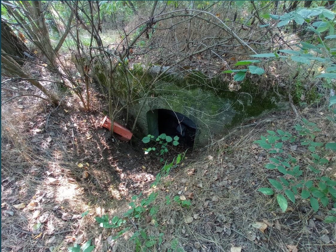
Betonfedezék, részlegesen földbe süllyesztve
