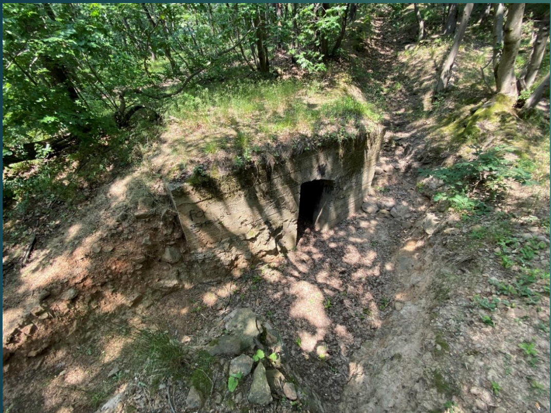
Betonfedezék a gyalogsági árokrendszerhez kapcsolva
