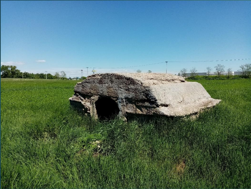
Betonfedezék sík terepen
