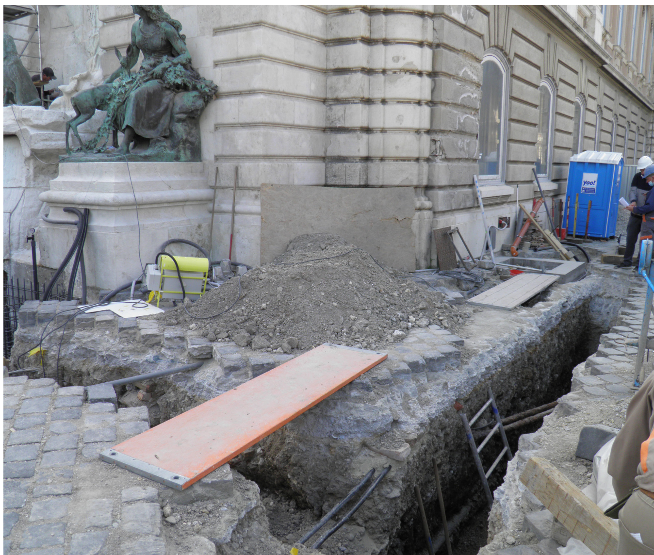
3. kép: Vízvezeték fektetése a Királyi Palota C épülete mellett (Fotó: Dr. Magyar Károly)
