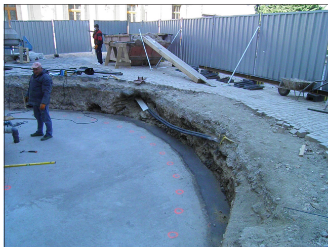
1. kép: A Mátyás-kút felújítás közben (Fotó: Dr. Magyar Károly)
