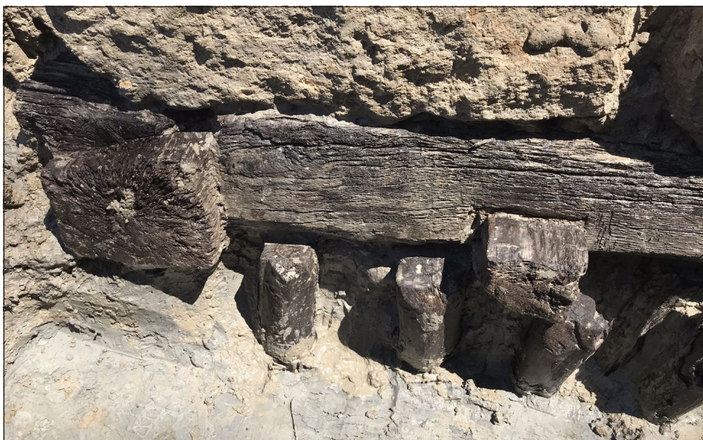
5. kép: A hídnylás déli oldalának kövekkel, cölöpökkel és gerendákkal alapozott konstrukciója
