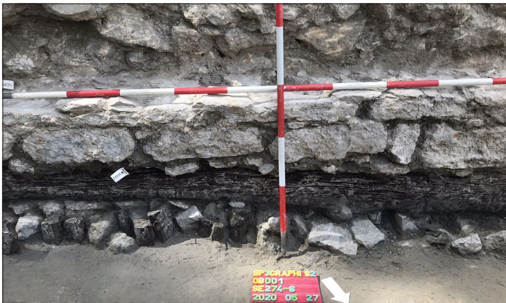
4. kép: Csapolt gerendaszerkezet és cölöpsor részlete a hídnylás északi oldalán (Fotó: Hajdu Barbara)
