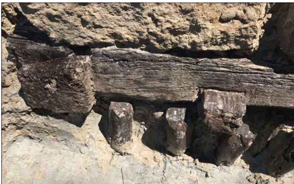
5. kép: A hídnylás déli oldalának kövekkel, cölöpökkel és gerendákkal alapozott konstrukciója (Fotó: Tóth Farkas Márton)
