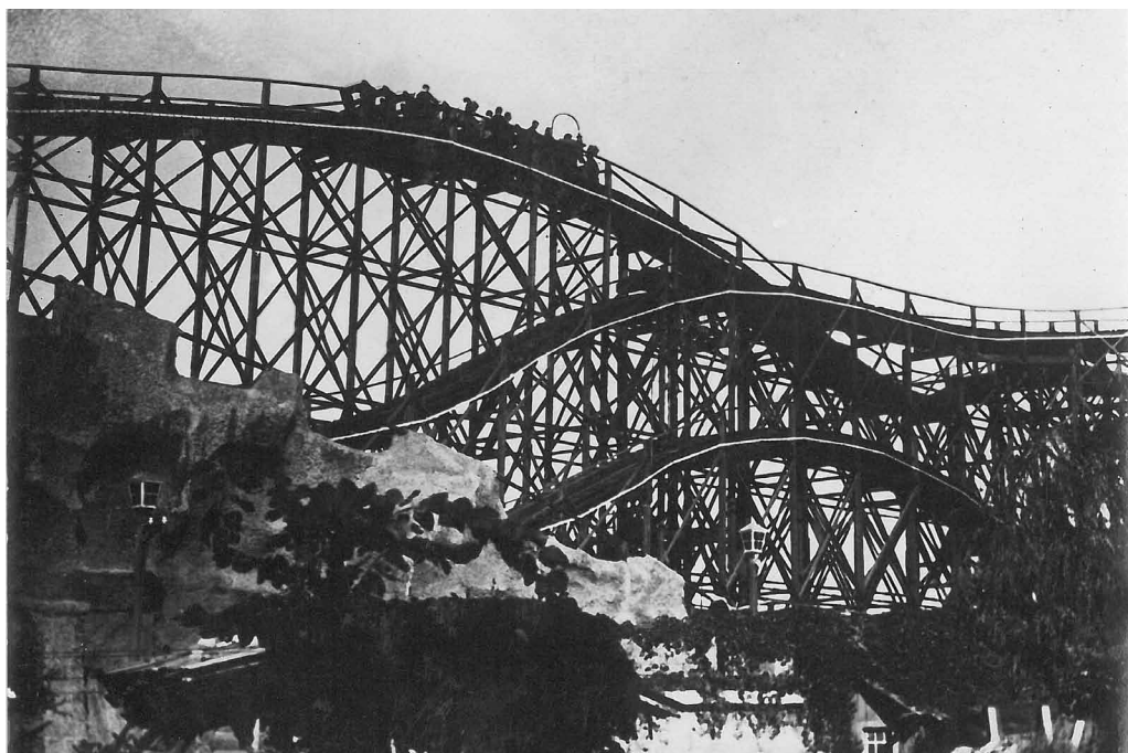
11. Hullámvasút. A fotó Szántó András tulajdona.
