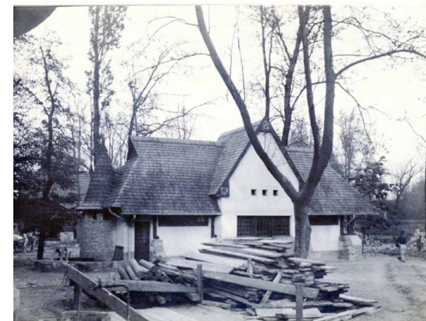
A kenguruház építés közben 1910. Fotó, Antony Gall tulajdona
