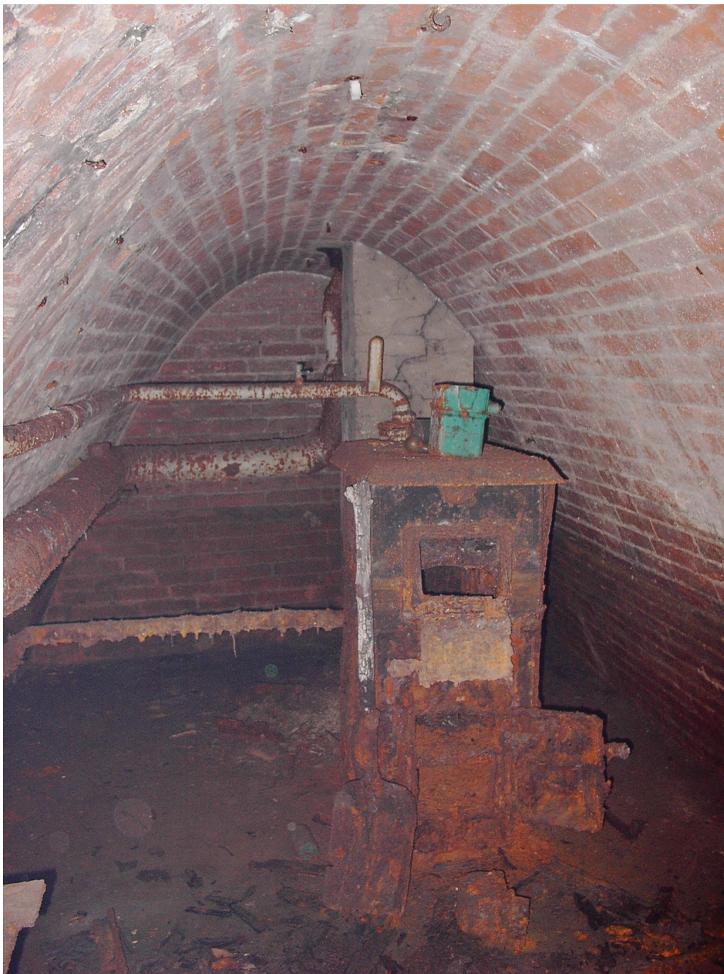
12. A barlangpince szinten egykor létező széntüzelésű kazán és mögötte a kémény. (A Szerző felvétele 2006. 07. 22-én.)
