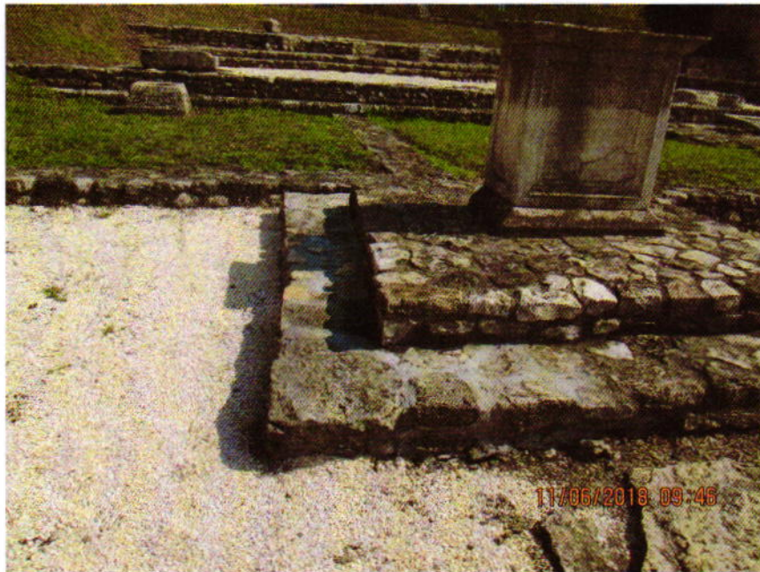
3. A főoltár talapzata a kijavított falalappal
