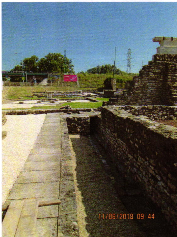
4. kép: A forum bejáratí folyosója a helyreállított keleti fallal és csatornával
