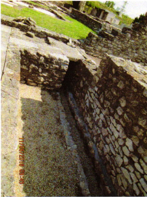
5. kép: A kijavított csatornaszakasz a forum bejáratánál, közelkép
