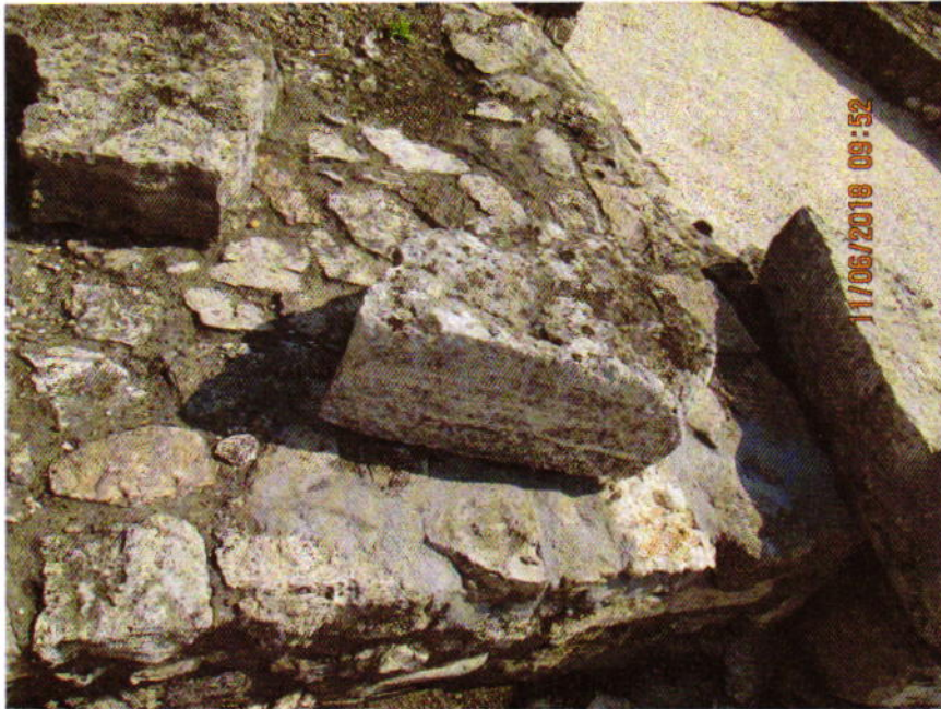
7. kép: A forumtemplom részlete a kifagyás után helyreállított falsarokkal
