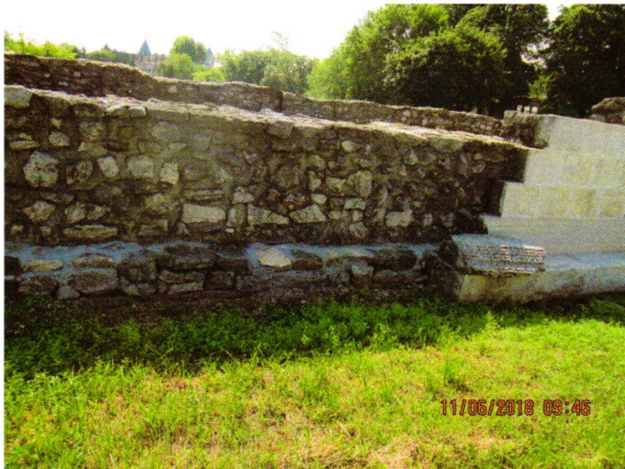
10. kép: A forum keleti zárófalának kifagyás után visszafalazott lábazata
